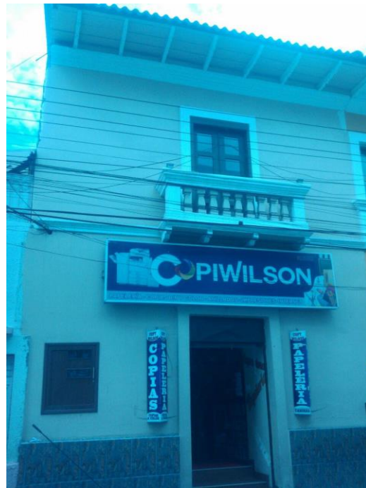
Figura 13. Edificio vista frontal
