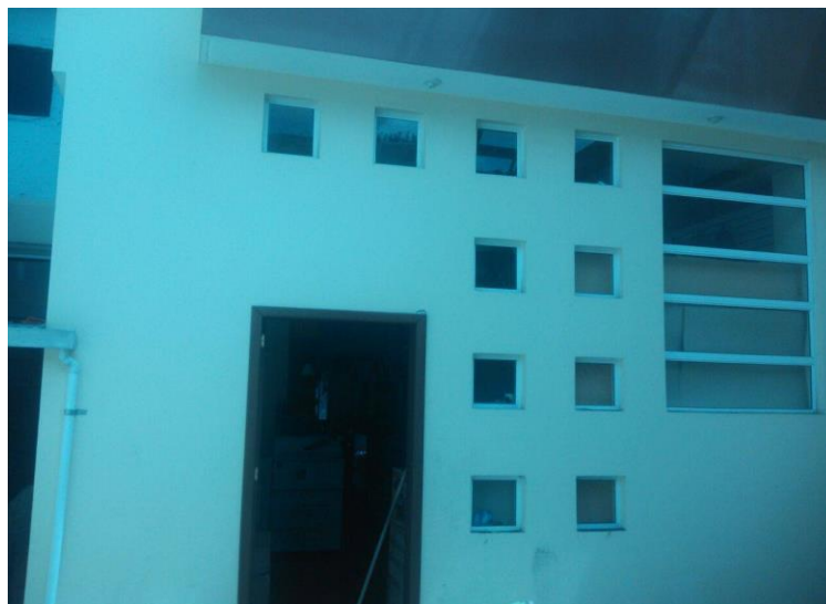
Figura16. Edificio vista posterior bodega
