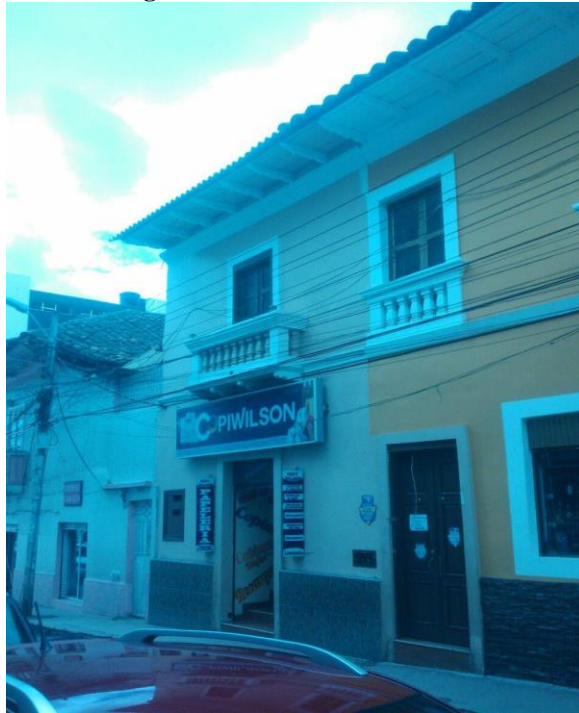
Figura 12. Edificio vista lateral
