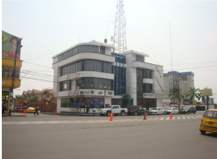
Figura 3. Edificio Radio y Tv Zaracay Matriz Santo Domingo
