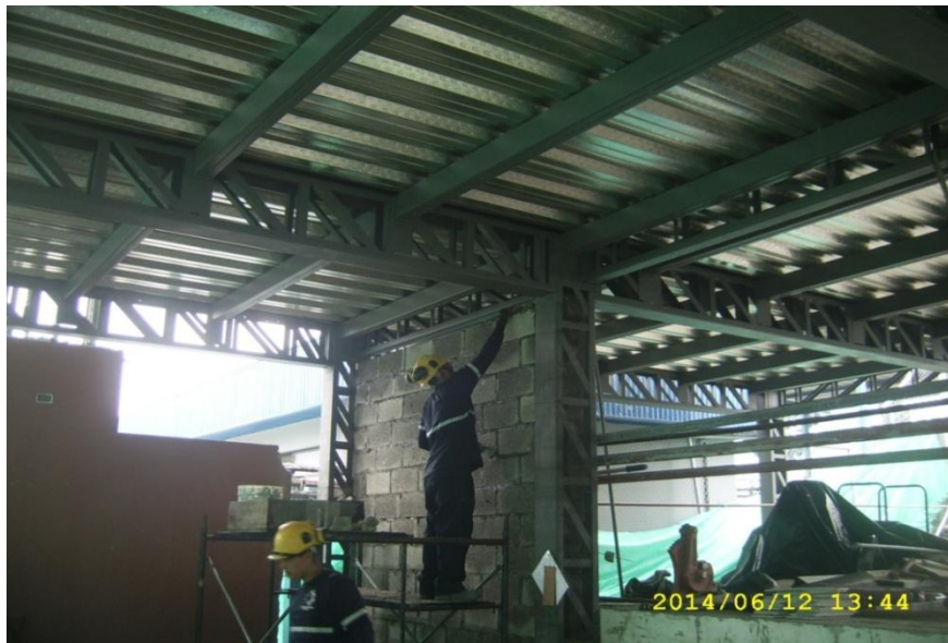
ESTRUCTURA Y COLOCACION DE PISO NOVALOSA
