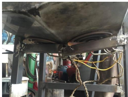
Figura 24. Instalación de resistencias eléctricas calentadoras.
