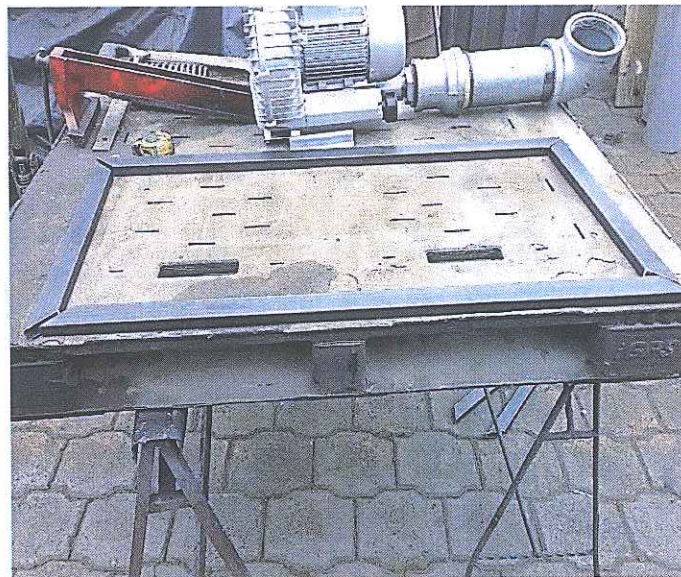
Figura 29. Armado de la estructura base
