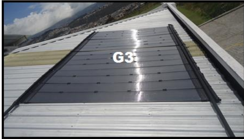
Figura 4.6 Distribución colectores solares techo NORTE piscina
