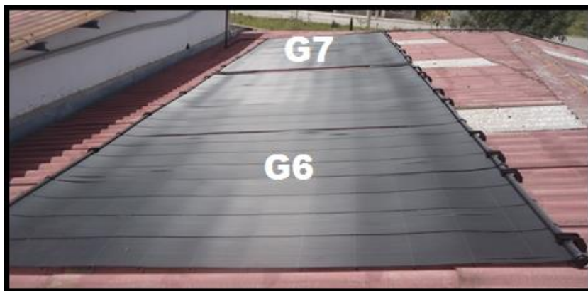
Figura 4.8 Distribución colectores solares techo NORTE vestuarios
