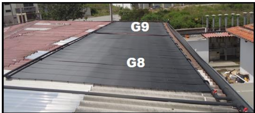
Figura 4.7 Distribución colectores solares techo SUR vestuarios
