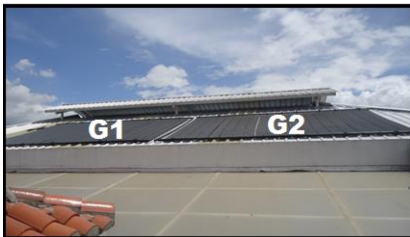
Figura 4.5 Distribución colectores solares techo ESTE piscina
