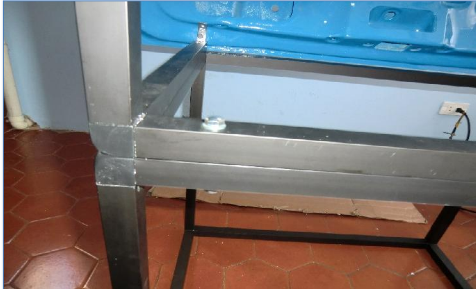
Figura 35. Colocación de la parte superior e inferior del Bastidor
