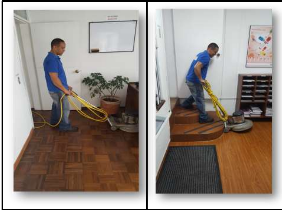
Figura 20. Posición del trabajador al ejecutar las actividades de pulido
