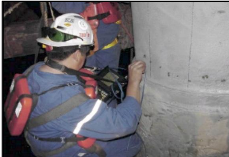
Figura 22. Inspección con ultrasonido de un ducto ascendente.
