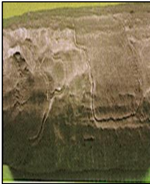
Figura 9. Corrosión por Oxígeno
