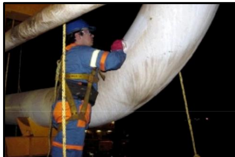
Figura 21. Inspección visual de un ducto ascendente
