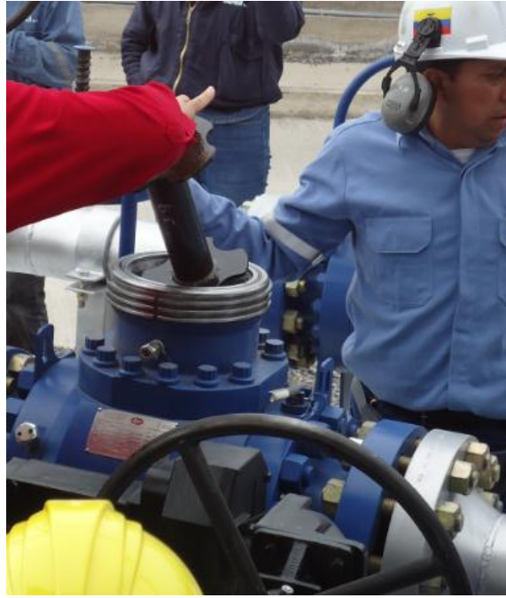
Colocación del PIG en la válvula de lanzamiento
