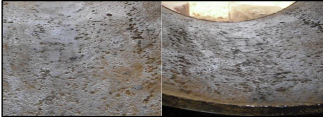
Figura 45. Vista interna, PK 147+749,331 superficie interna – limpieza mecánica
