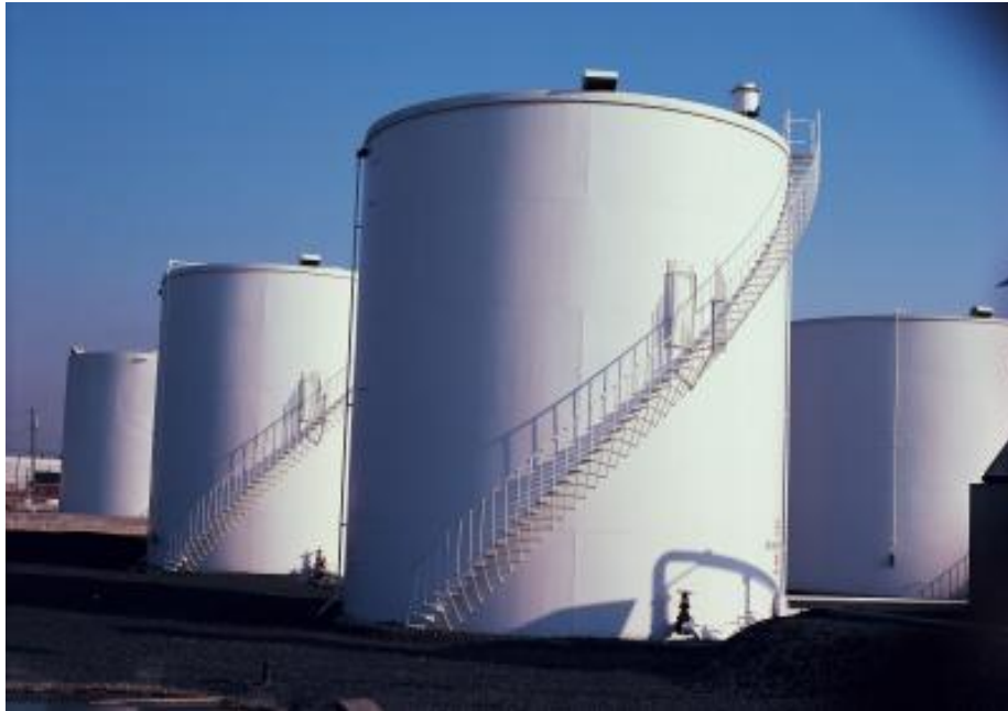
Figura 3. Tanque de techo cónico
