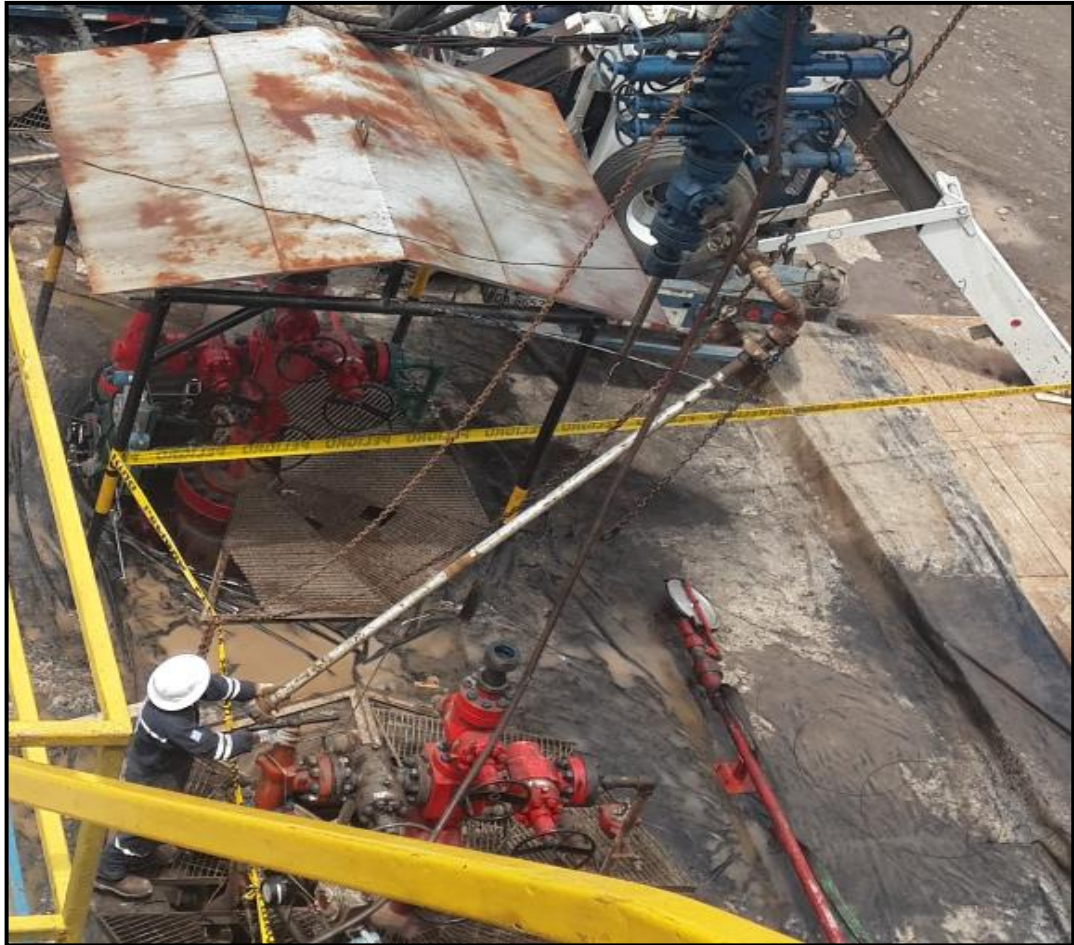
Figura 68. Conexión de la punta del Coiled Tubing al cabezal del pozo
