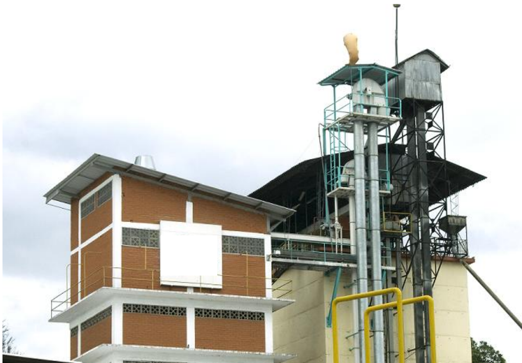
Figura 21. Silos de la Planta Cervecera
