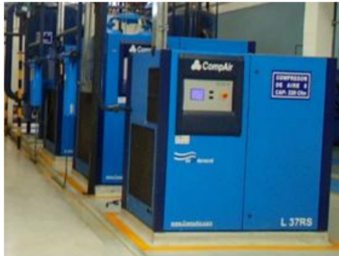
Figura 34. Sistema de Aire de la Planta Cervecera (Cervecería Nacional, 2014)
