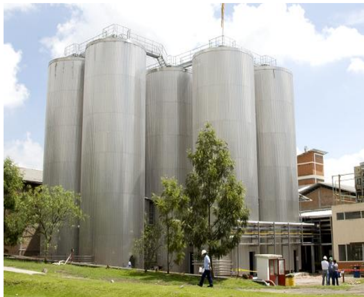
Figura 27. Tanques Fermentadores y Maduradores cilindro cónicos (Cervecería Nacional, 2014)
