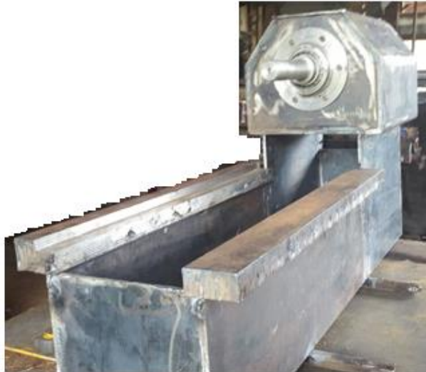
Figura 51. Ensamblaje del cabezal y bancada
