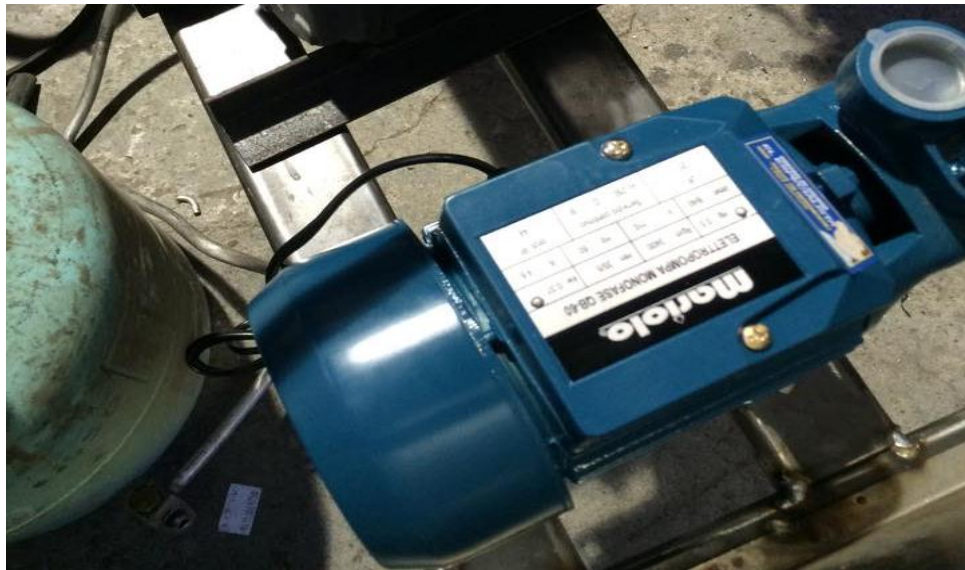
Figura. 35 Montaje bomba de agua
