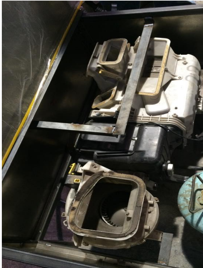
Figura. 37 Montaje blower y ducto de ventilación
