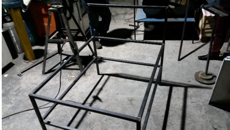
Figura 30. Soldadura de la estructura metálica.
