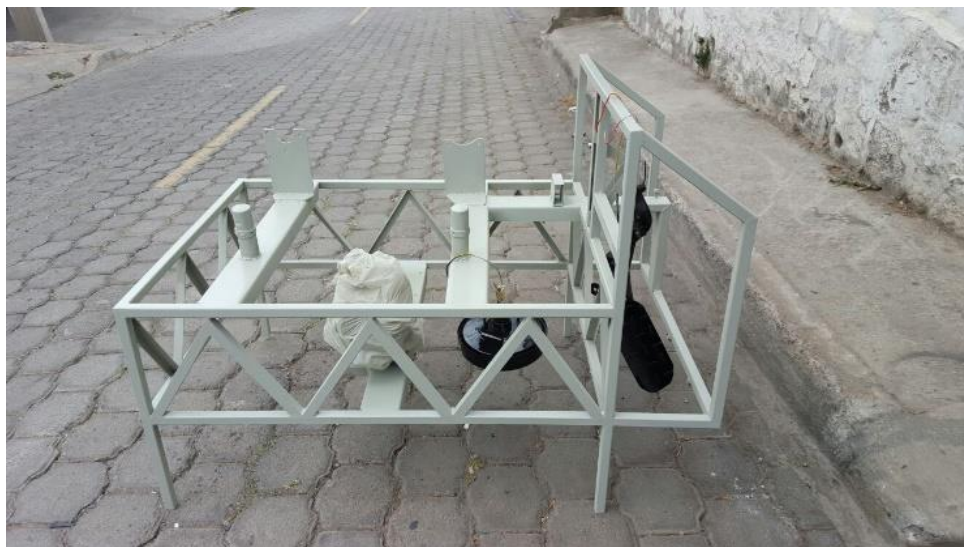
Figura 31. Pintura de la estructura.
