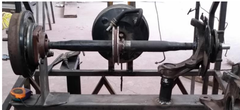
Figura 36. Colocación de la transmisión.
