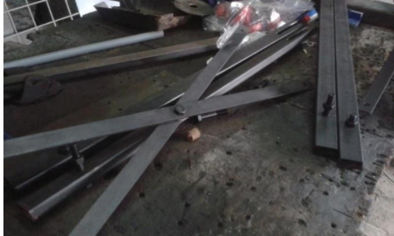
Figura 4.21. Armado de sistema de tijeras.
