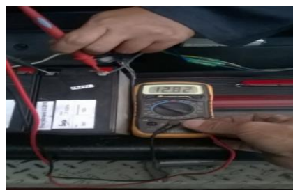
Figura 96. Medición de carga de las baterías
