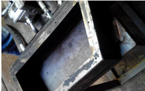
Figura 48. Depósito de aceite en construcción
