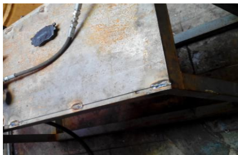
Figura 47. Construcción de la estructura metálica
