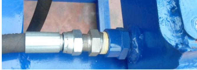
Figura 61. Ensamblaje de cañería
