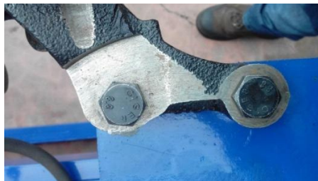
Figura 70. Sujeción de la mangueta en la estructura
