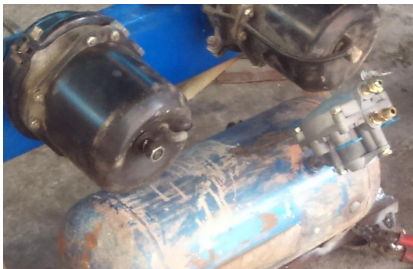
Figura 44. Instalación de válvula relé sobre tanque de aire.
