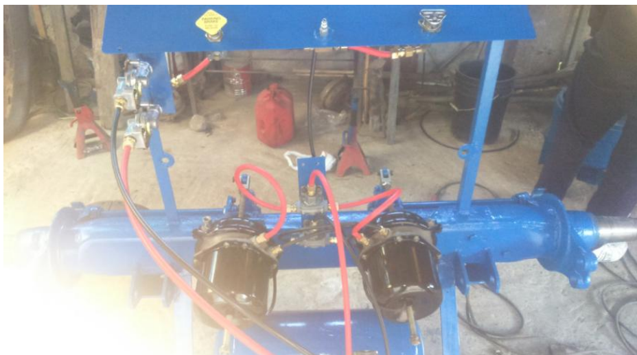
Figura 46. Instalación de mangueras plásticas para circuito de frenos.
