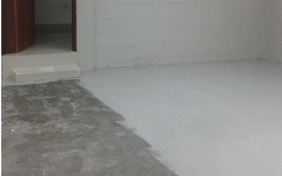
FIGURA 29. APLICACIÓN DE PINTURA EPOXICA
