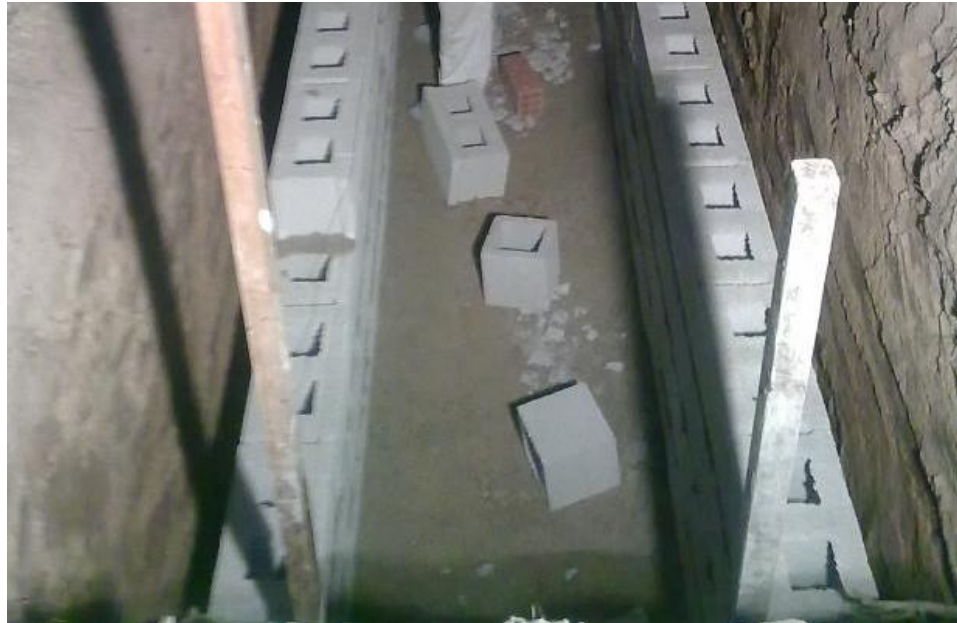
FIGURA 27. FOSA DE SOLDADURA
