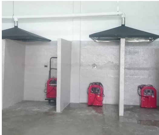
FIGURA 37. CABINAS DE SOLDADURA
