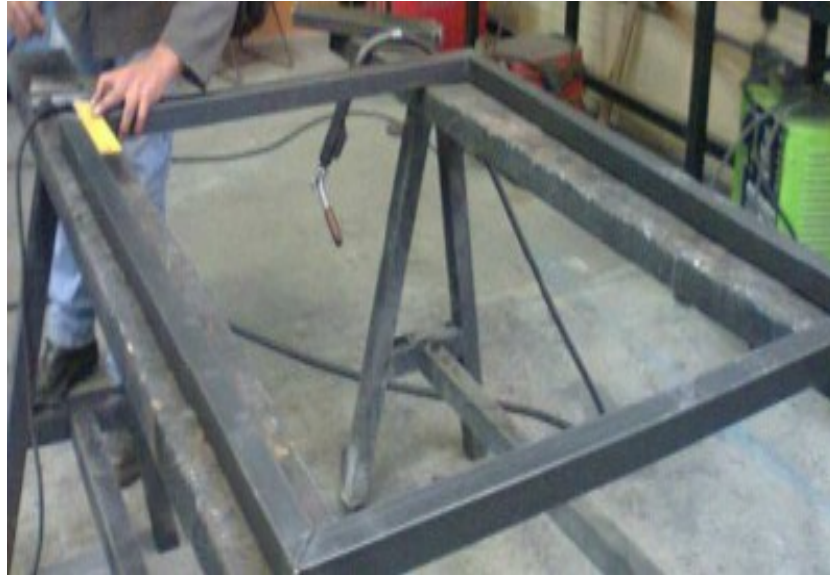
Figura 65. Base de la estructura
