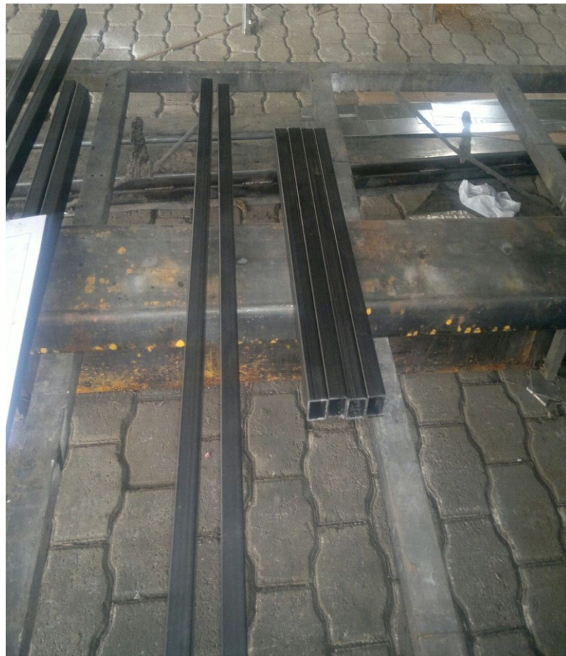
Figura 64. Piezas de la estructura metálica
