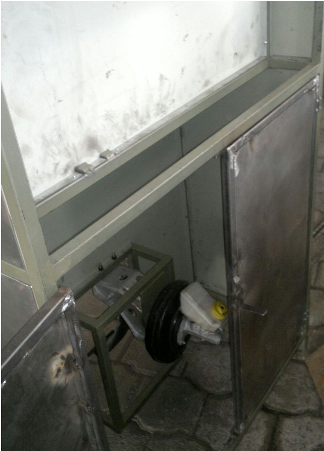
Figura 76. Puerta trasera de la estructura y el servofreno instalado
