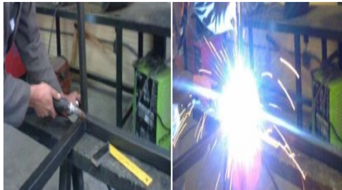
Figura 67. Soldadura de tubos que servirán para los soportes
