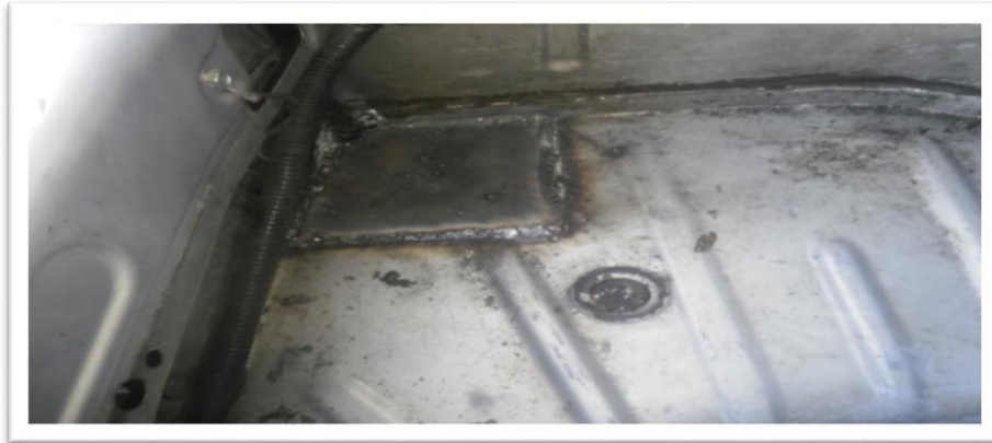
Figura 58. Soldadura de bases de jaula de seguridad
