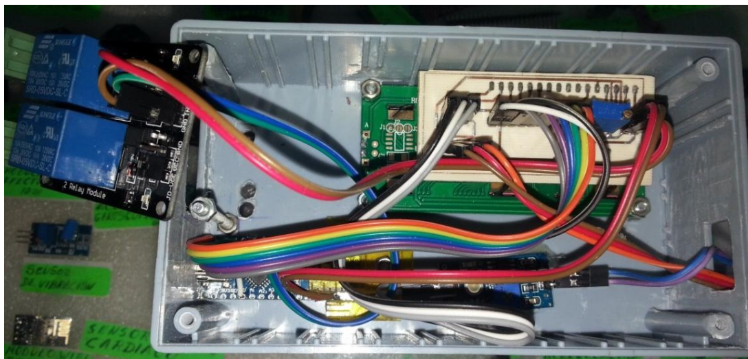
Figura 58. Módulo electrónico finalizado.
