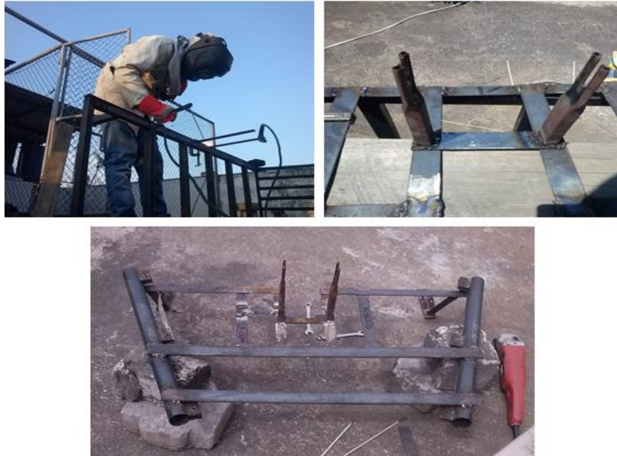
Figura 68. Fabricación de estructura metálica
