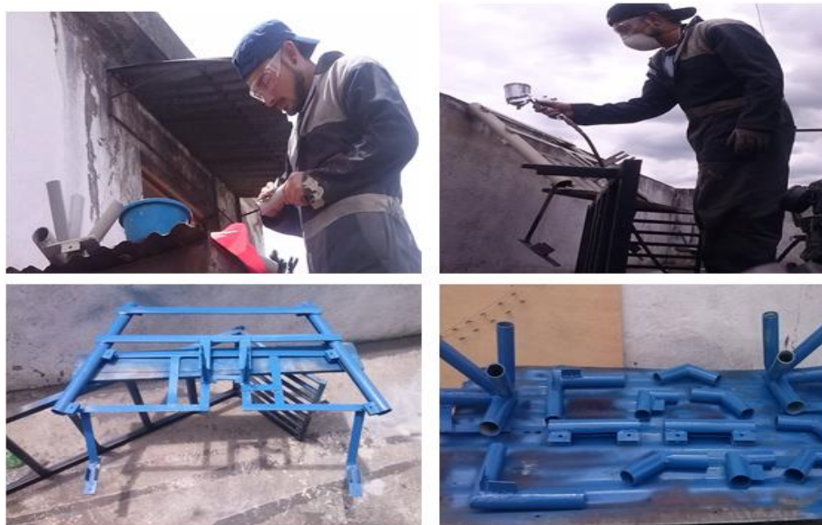
Figura 72. Aplicación de fondo y pintura en acero
