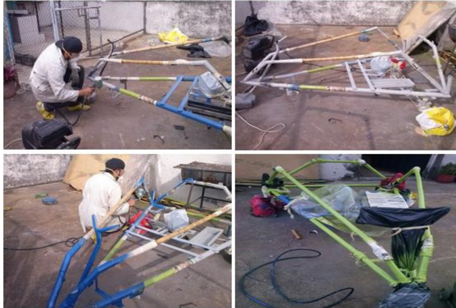
Figura 75. Unión y pintura de todos los elementos de la estructura
