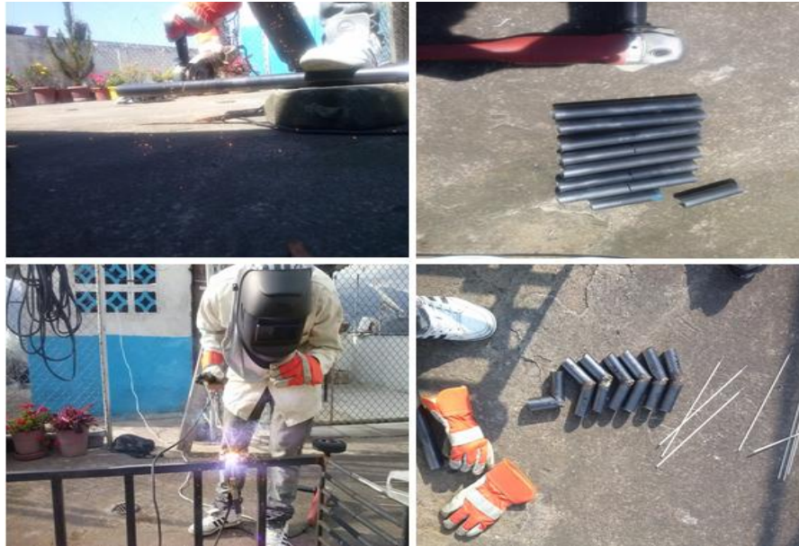
Figura 66. Fabricación de guías metálicas
