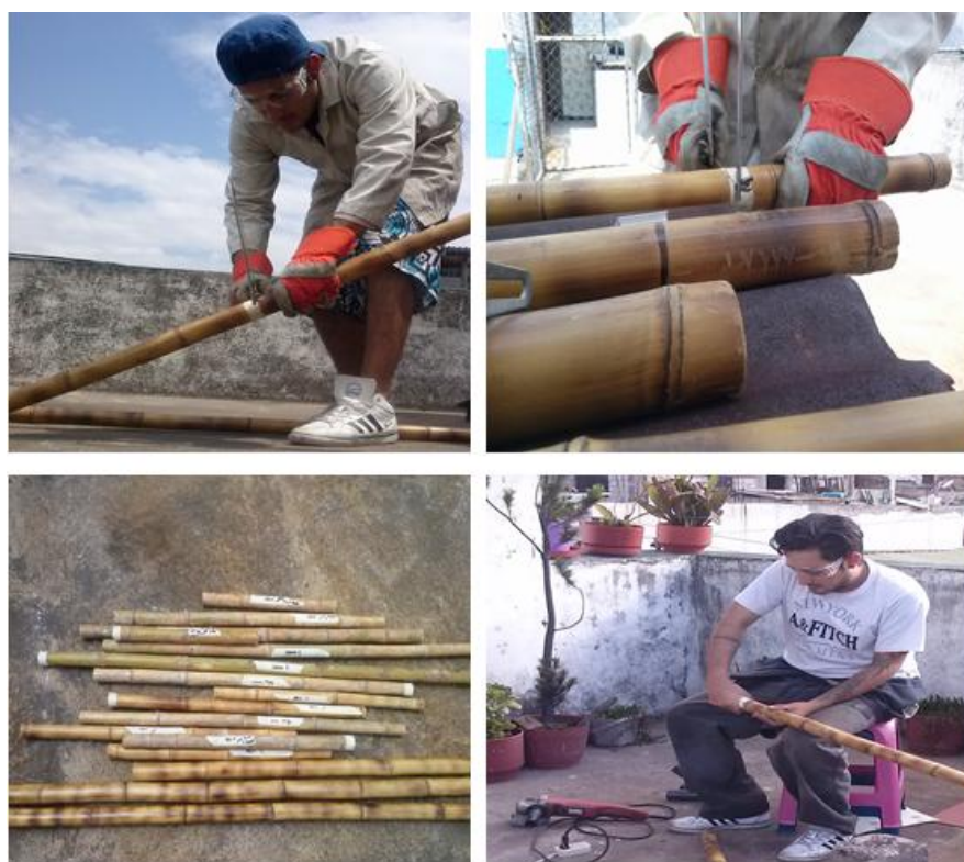
Figura 71. Corte y lijado de bambú
