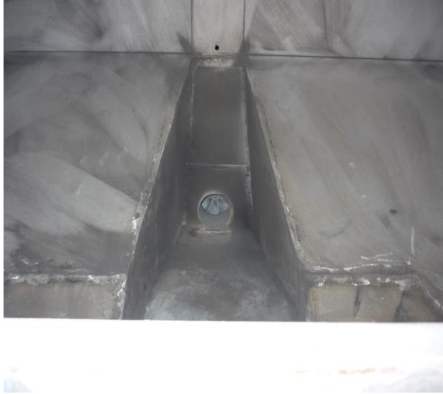
Figura 31. Ventiladores para extracción de polvo en cabina de pintura
