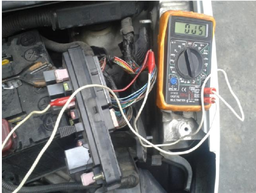
Figura 48. Prueba de encendido y continuidad.
