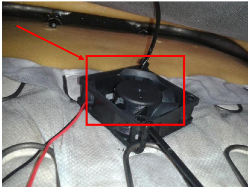
Figura 39. Instalación de alarma vibradora.
