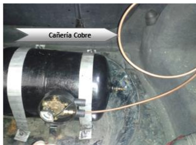
Figura 58. Colocación cañería de cobre
