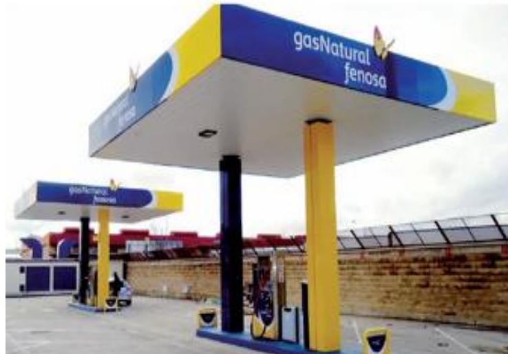
Figura 29. Estación de Suministro de G.N.C. Perú (G.N.C. Energía Perú, 2013)
