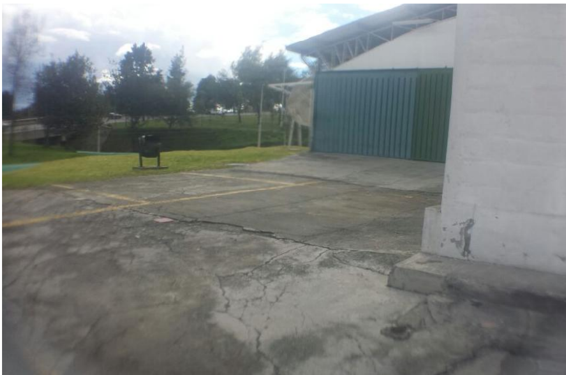
Figura 68. Área de circulación vehicular previa al rotulado
