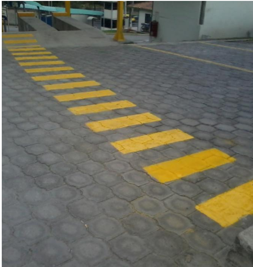
Figura 64. Zona de Seguridad terminada
