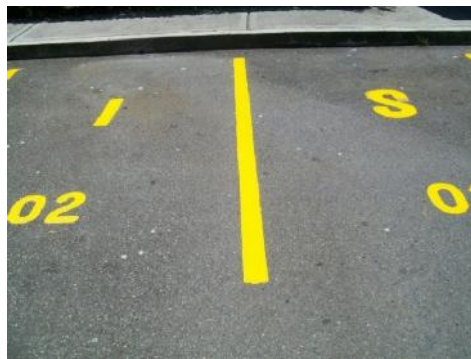
Figura 2. Señalización horizontal (ANBASRIN Marcas Viales, 2014)
