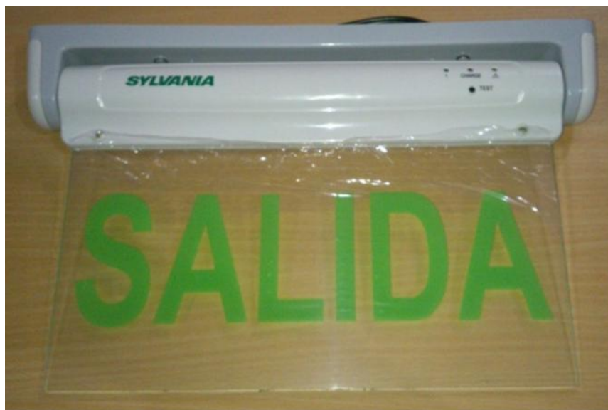
Figura 56. Instalación de rótulo de salida
