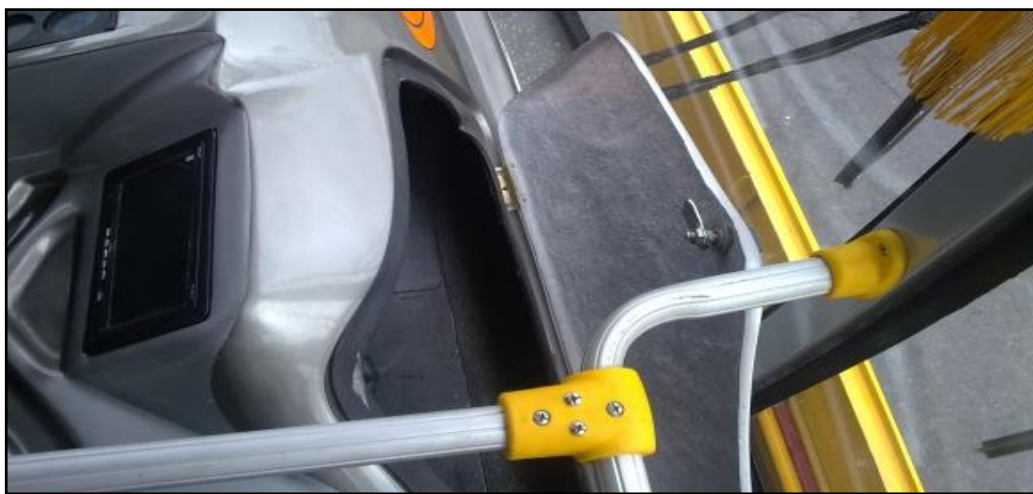
Figura 41. Ubicación no adecuada de la caja de fusibles
