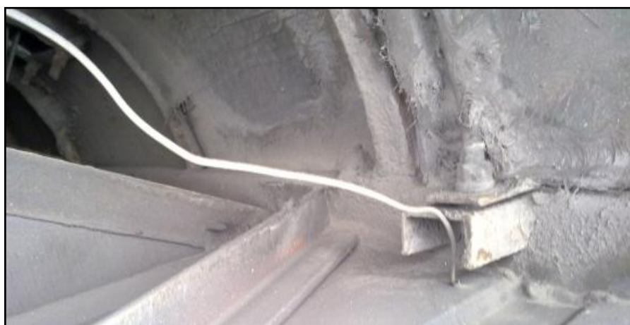
Figura 46. Arnés de cables de carrocería sin protección y sin sujeción (Taller Eléctrico Chávez, 2014)
