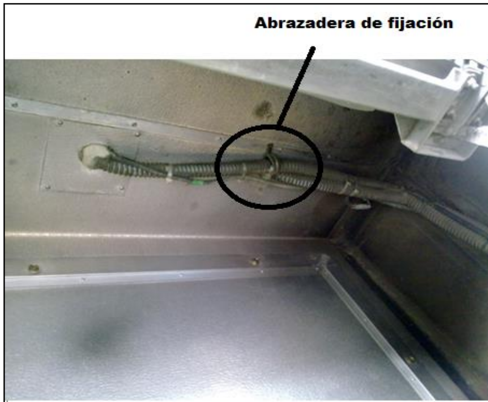
Figura 160. Fijación y paso de arnes, carrocería Marcopolo Paradiso 1200 (Taller Eléctrico Chávez, 2014)
