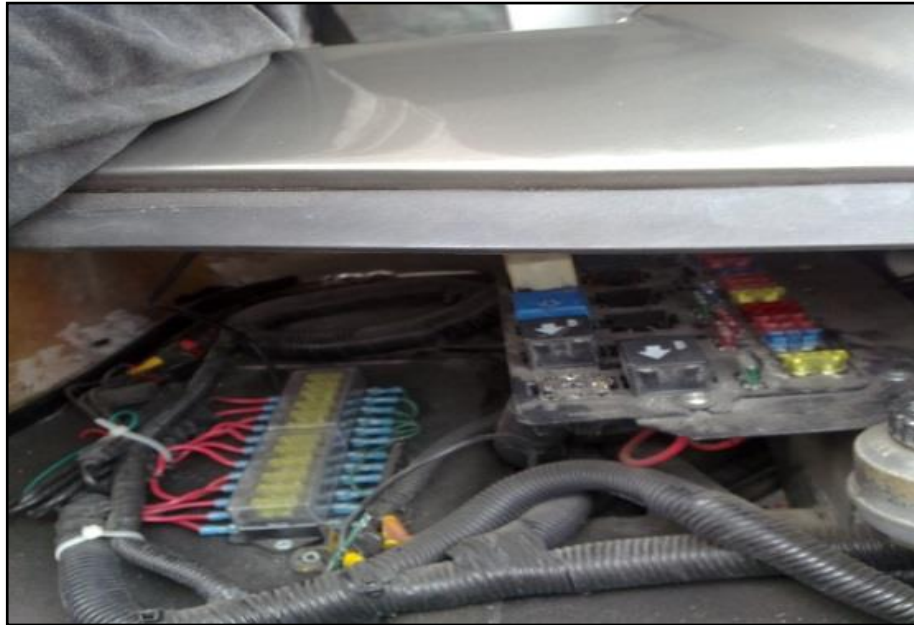
Figura 42. Ubicación no adecuada de la caja de fusibles (Taller Eléctrico Chávez, 2014)
