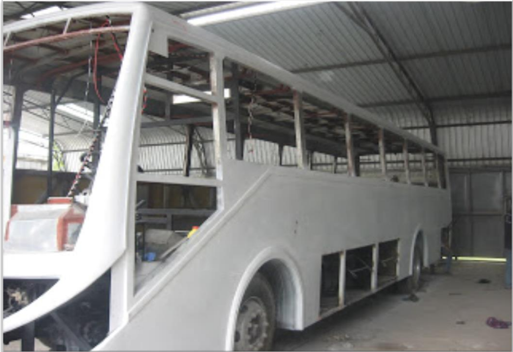
Figura 10. Preparación de la Carrocería (Construcción de un bus, 2012)
