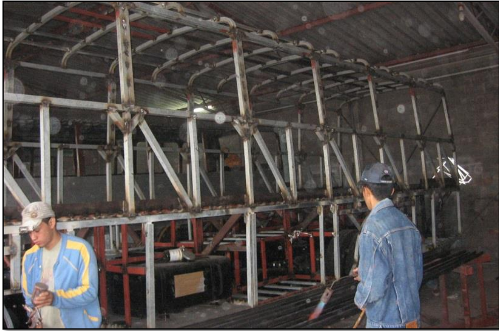
Figura 6. Unión de la Estructura
