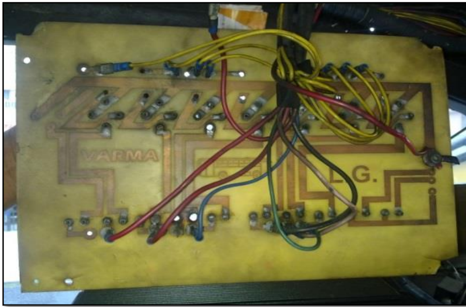
Figura 39. Tablero de fusibles (Diseño propio de la empresa carrocera) (Taller Eléctrico Chávez, 2014)
