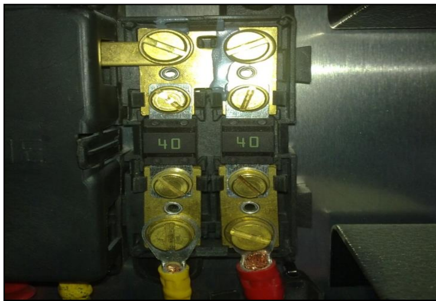
Figura 135. Bornera positiva para toma de corrientes volksbus (Taller Eléctrico Chávez, 2014)
