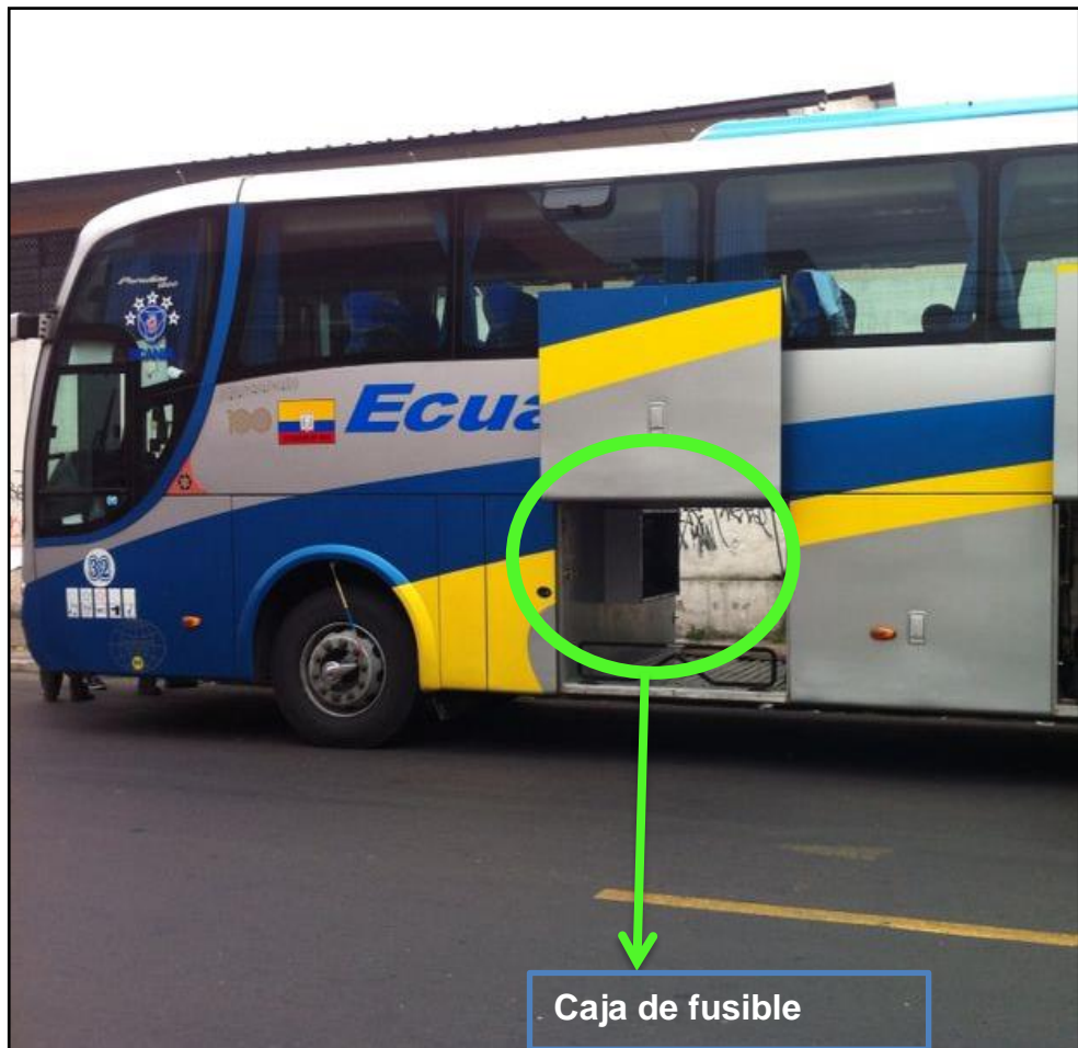
Figura 116. Caja de fusible en bodega de equipaje (Taller Eléctrico Chávez, 2014)
