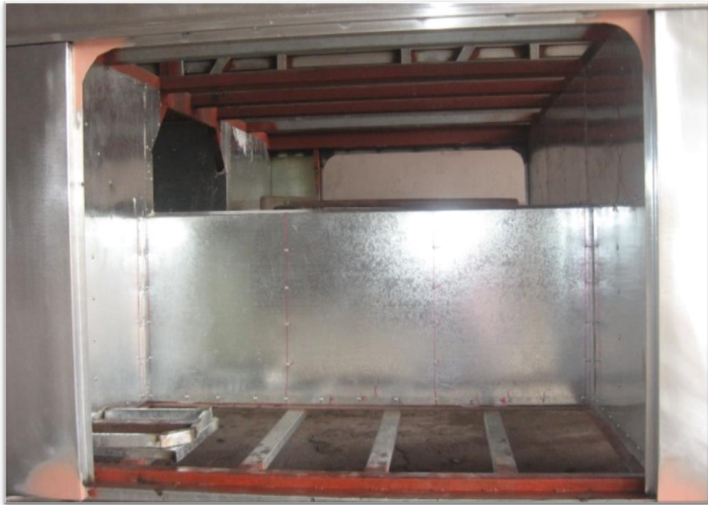
Figura 8. Forro de cajuelas (Construcción de un bus, 2012)
