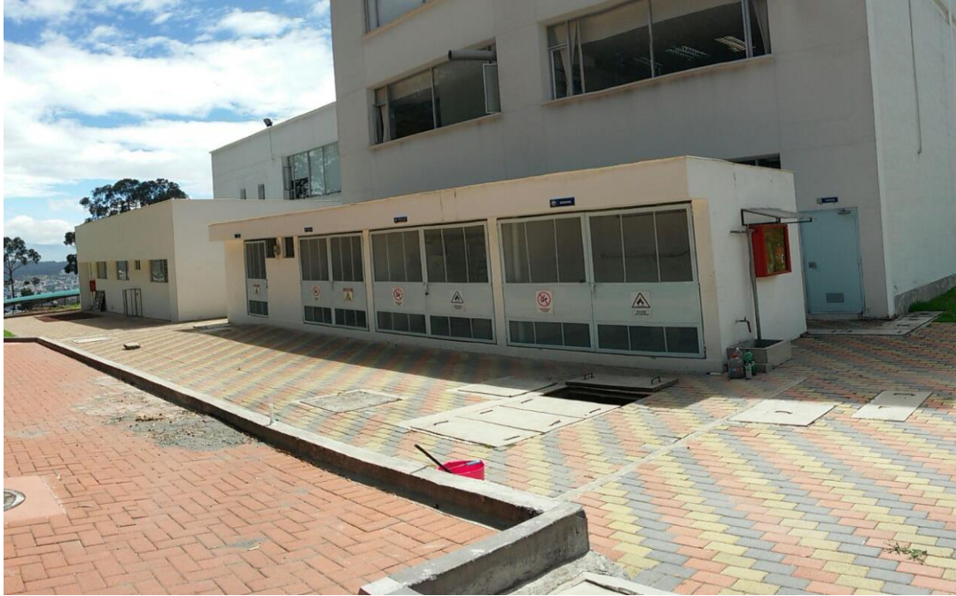
Figura 1. Ubicación de la trampa de grasas de la planta de alimentos dentro de la Universidad Tecnológica Equinoccial.
