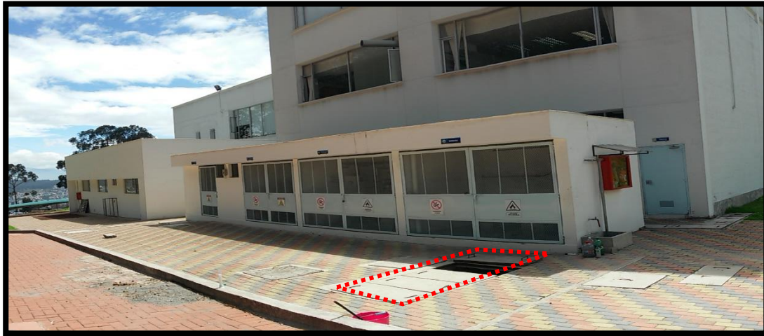
Figura 9: Ubicación de Trampa de Grasas fuera de la planta piloto de alimentos.
