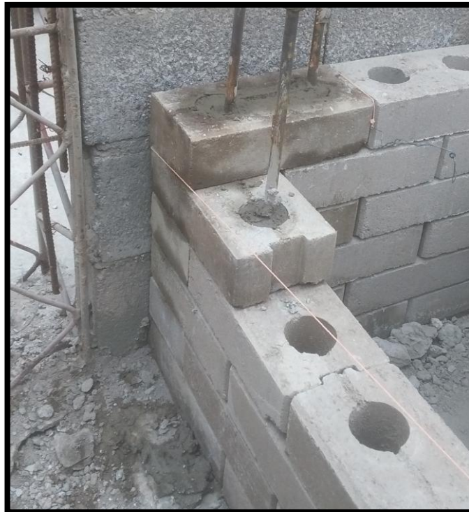
Refuerzo en las esquinas del cuarto
