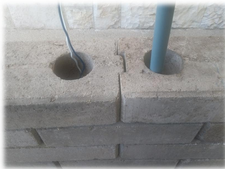
Figura 5. Agujeros verticales, facilitan instalaciones: eléctricas, agua o gas
