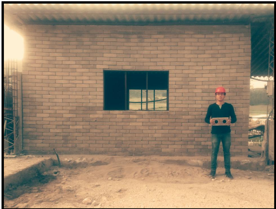
Cuarto construido con ladrillos ecológicos propuestos
