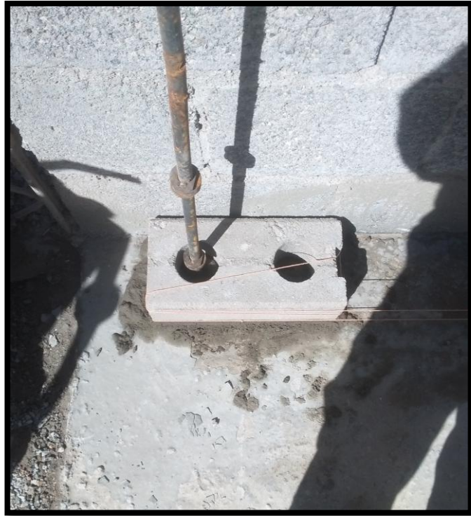
Colocación del primer ladrillo ecológico
