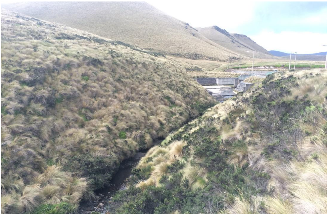
Figura 11. Río Jatunhuaycu aguas debajo de la captación.
