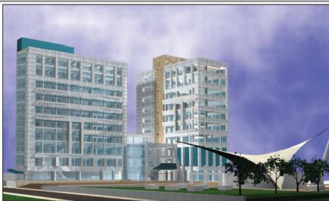
Imagen panorámica del nuevo campus de la FLACSO. El edificio contará con espacios acorde a las necesidades pedagógicas.
