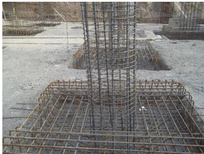
Ilustración 67: Cimentación de Columna Circular Fuente: www.espe.edu.ec
