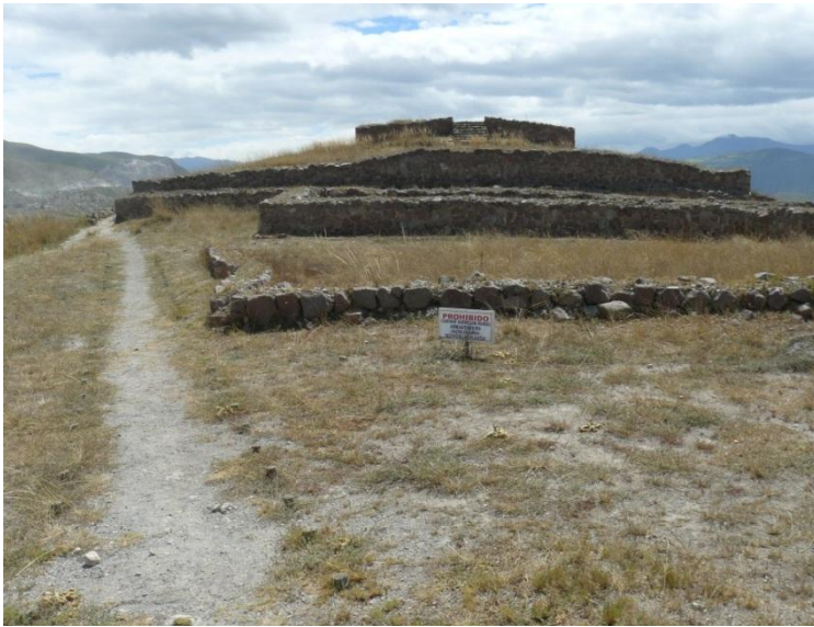
Acceso al Pucará de Rumicucho donde se evidencian los muros de contención.
