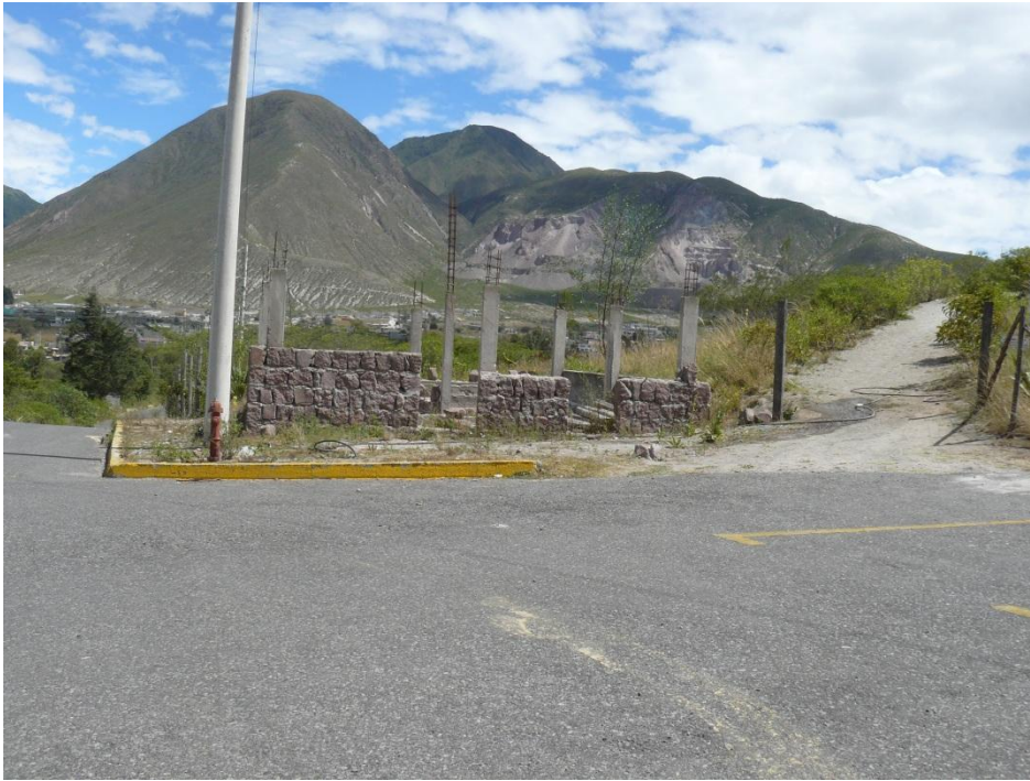
Parqueadero e ingreso al Pucará con construcción no terminada.
