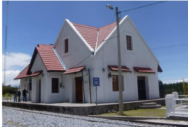
Fotografía 2.39. Estación del tren El Boliche
