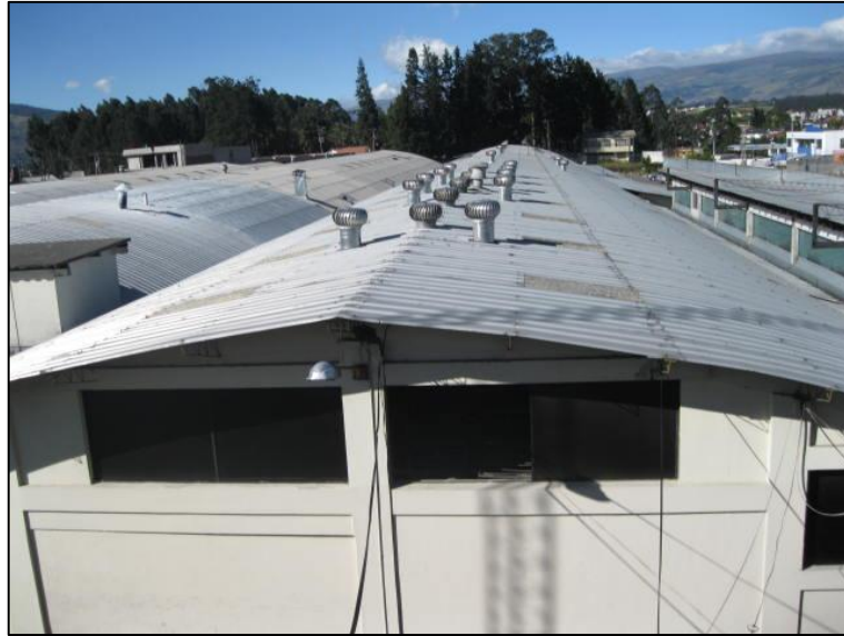
Figura 8. Cubierta de Tol galvanizado
