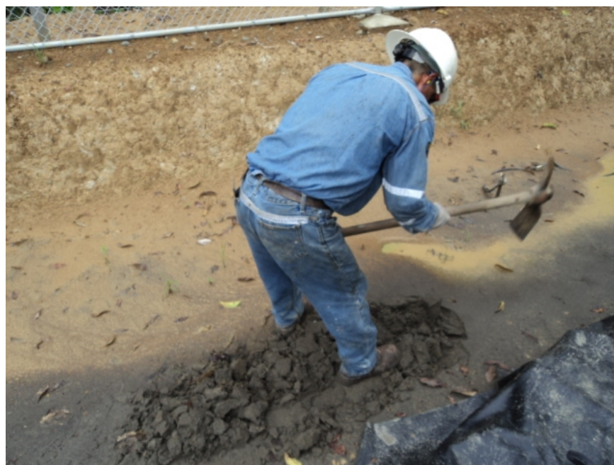
Uso herramientas para apertura de zanjas de contención
