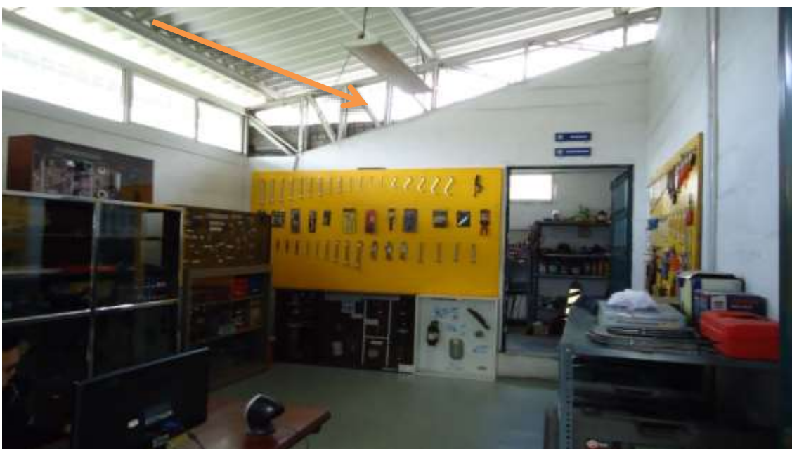
Gráfico 5.5 Separación de mampostería con cubierta
