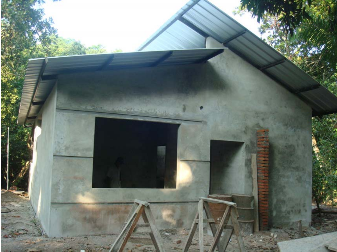
Planta de procesamiento en etapa de implementación.
